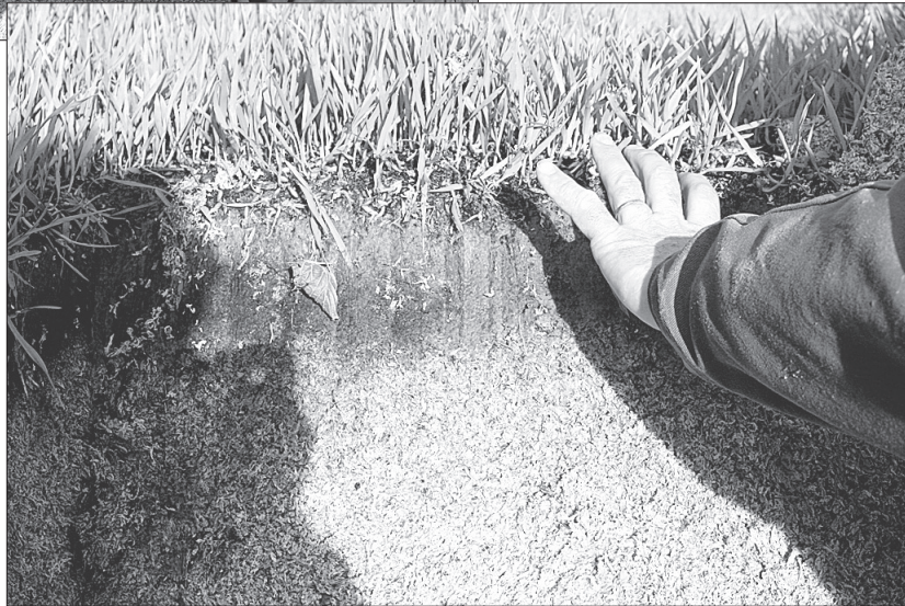
Il se forme deux couches, le chevelu racinaire et une sous-couche de compostage qui assure l'étanchéité.
