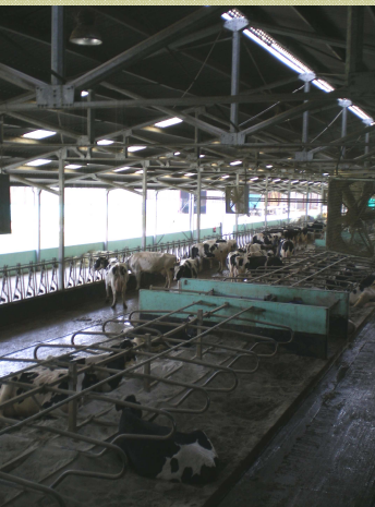
Bâtiment de 120 logettes sur sable fin = très grand confort pour les animaux.
