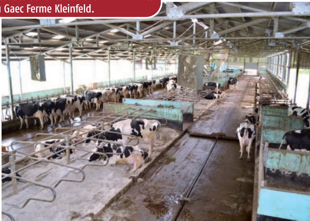
102 m de long, pour ce bâtiment qui compte 172 logettes adultes et génisses à partir de six mois. Au gaec Ferme Kleinfeld.
